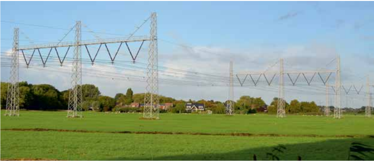
Het dorp ‘onder de rook’ van de hoogspanningsmasten - foto Gerard Boer
