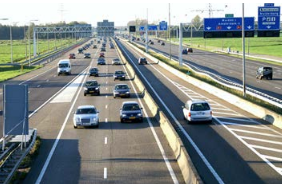
A1 richting Amsterdam vanaf viaduct Googweg - foto Gerard Boer
