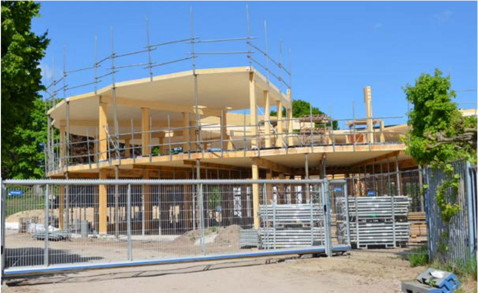
De Meerstroom in aanbouw 1 mei 2025 - foto Gerard Boer
