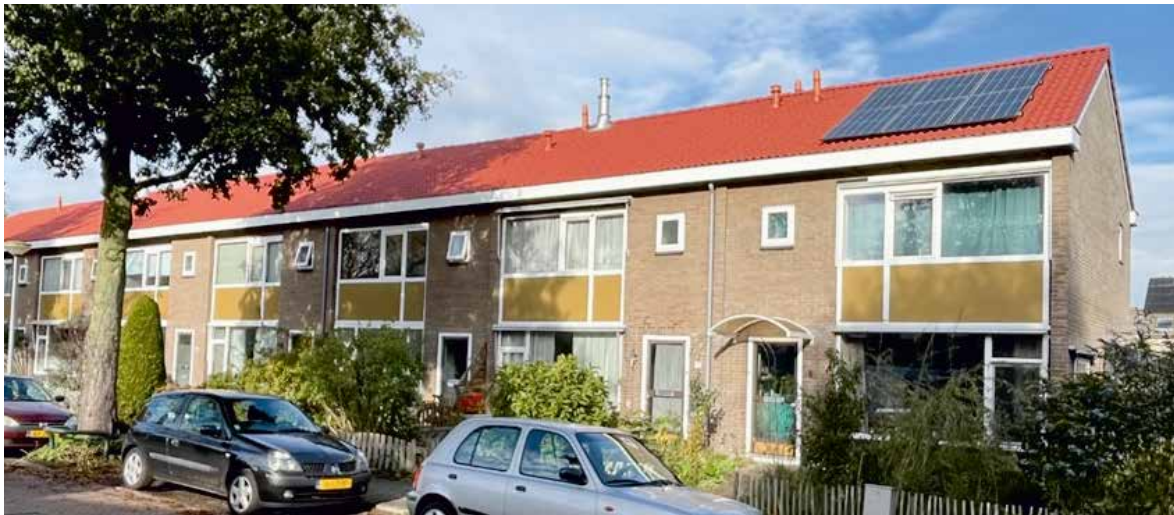
De twee huizenblokken aan de Paulus Potterlaan 3-18 gezien vóór, tijdens en na de renovatiewerkzaamheden foto's Arnold Niesing
